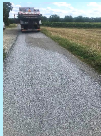
Gravillonnage route de Chante à Gré
