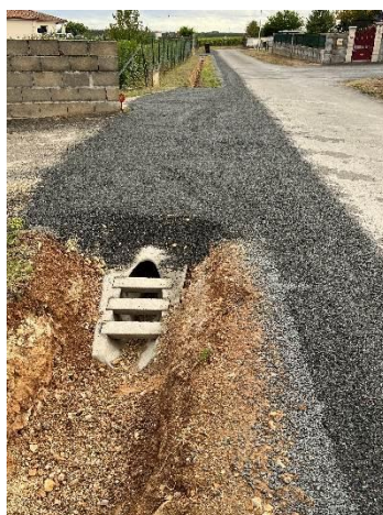
La croisette, rue des blés : Déviation des eaux de ruissellement, creusement et changement des canalisations
