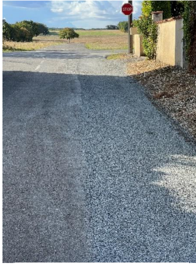
Rue du cerisier négrier / RD14 : rehaussement de la chaussée
