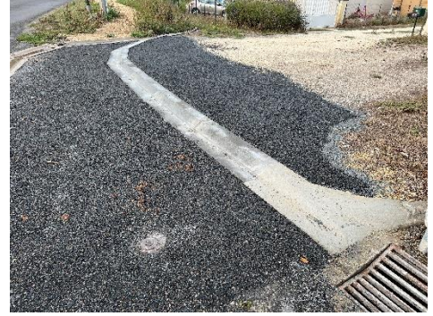
Rue froide / RD14 : Déviation des eaux de ruissellement, creusement et changement des canalisations
