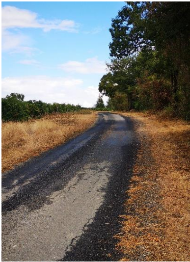
Réfection de la chaussée rue du Chêne Vert à Villars et rue des Passeroses dans le bourg
