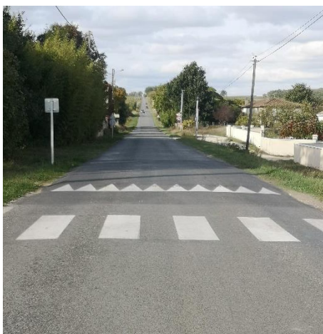
Aménagement de sécurisation de la RD 14 opérationnel depuis fin Mai
