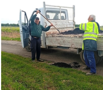
Avril 2026 : Élus et agents ont réalisé deux opérations de rebouchage après les fortes pluies hivernales. Plus de 5 T d'enrobé ont été utilisées pour réparer les chaussées les plus endommagées.
