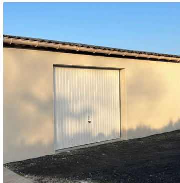
Février 2026 : Fin des Travaux au local des chasseurs réalisés par l'Amicale des propriétaires chasseurs et non chasseurs
